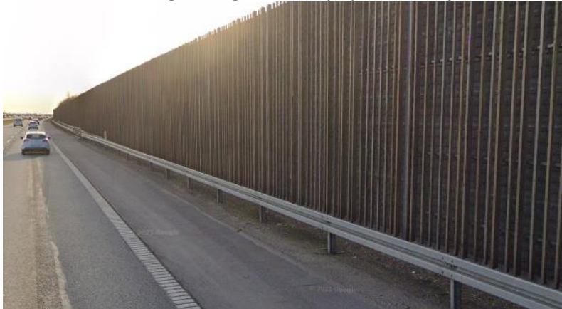
Figur 6: Støjskærm ved Bjæverskov, 5 meter høj
