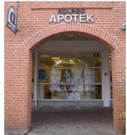
Figur 16: Eksempel på skiltning med løse bogstaver placeret midt over buet arkadeåbning. Udhængsskiltet har samme farveholdning som facadeskiltet.
