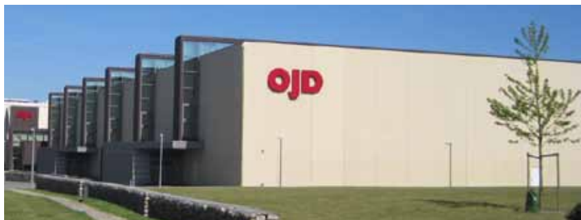
Figur 43: Eksempel på skiltning der er tilpasset bygningens arkitektur.
