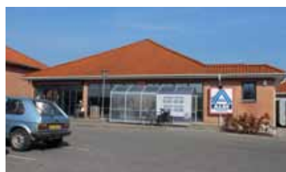
Figur 37: Eksempel på skiltning ved Jersie Center i Jersie Strand.
