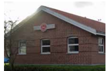
Figur 49: Eksempel på pladeskilt placeret midtfor i gavltre-kant således, at det harmonerer med vinduesplacering og designet i farver der harmonerer med facadens farveholdning.
