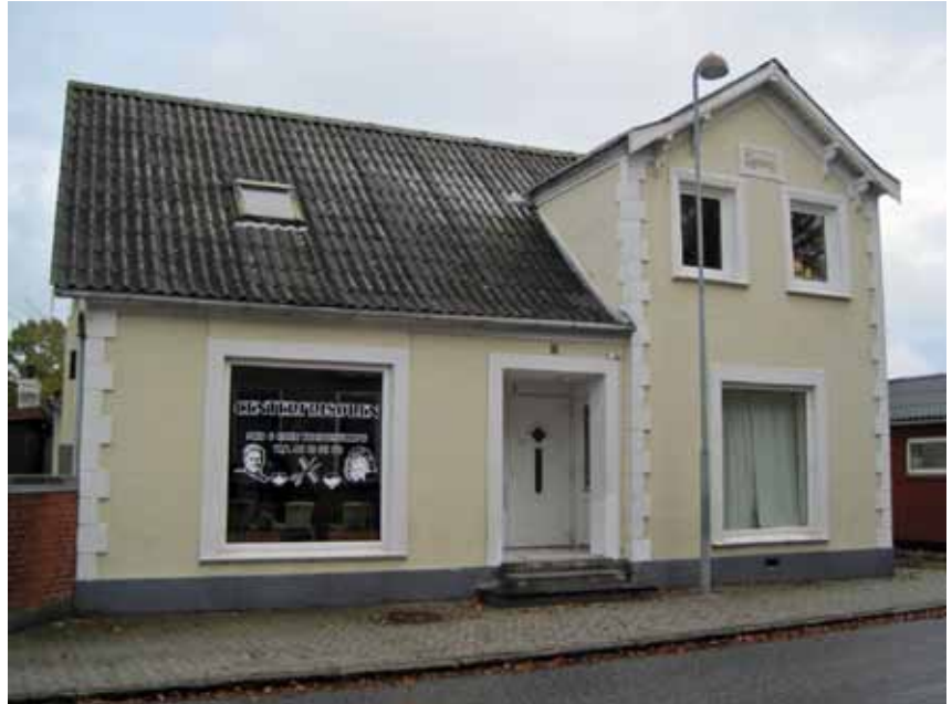
Figur 27: Hvis der ikke er plads til skiltning over ruder eller indgangsdør, kan man skilte på ruden som her ved dette eksempel. Skiltningen er udformet med løse transparente bogstaver og logo, der er påklæbet ruden.
